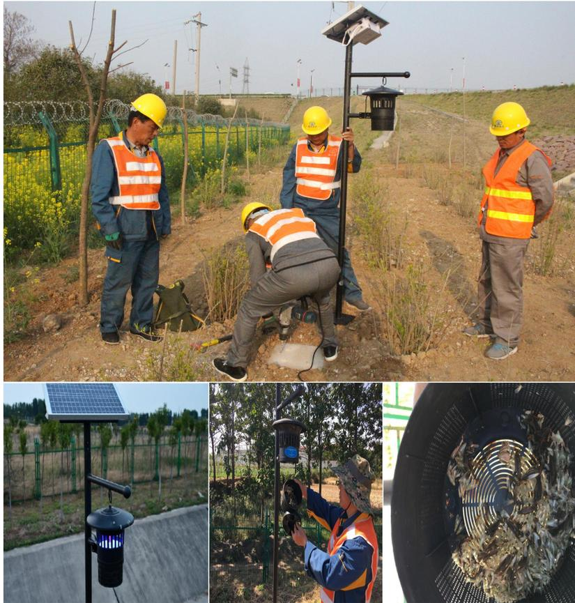
图 7 南水北调中线干渠平顶山段白蚁诱捕灯布置、安装及效果图
