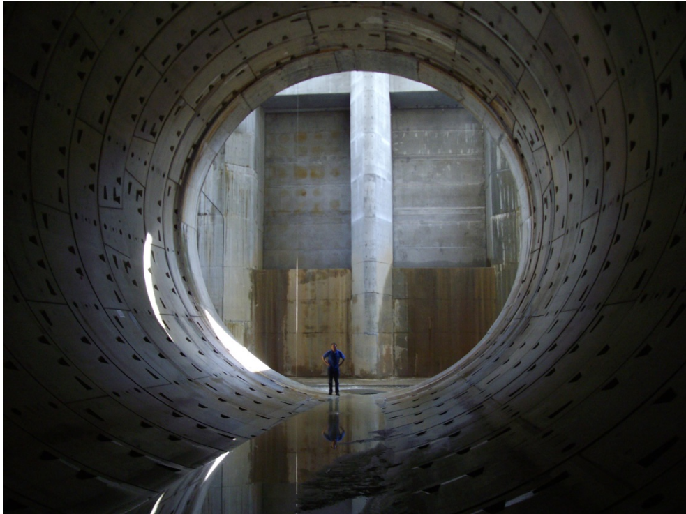
11.8米直径和12公里长的吉隆坡SMART隧道，与它连接的蓄水池可以容纳4百万立方米的水量，可转移洪水对市区的冲击。
